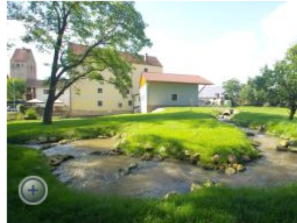
Fischtreppe Neckermühle in Bad Gögging
